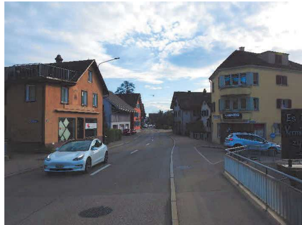
Abbildung 61: Zürcherstrasse, rechts das Geländer der Fussgängerunterführung (SB&LE)
