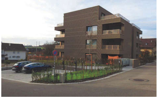
Abbildung 31: Die Gebäude wurden durch einen Neubau mit Wohnungen ersetzt (SB&LE)
