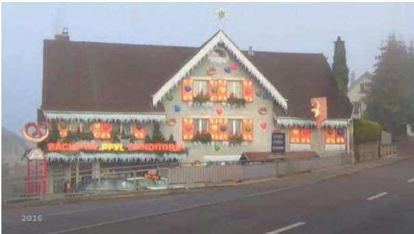
Abbildung 102: Eine Bäckerei war schon ca. 1907 (oben) in diesem Haus. Dieses war früher direkt an die Zürcher Strasse angeschlossen, wegen dem Bau der Fussgängerunterführung, wurde der Zugang abgeändert, wie 2016 (unten) sichtbar ist. (Hedingen 2)
