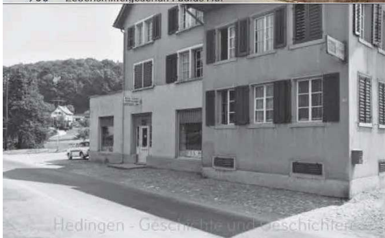
Abbildung 110: Hauptstrasse (heute Zürcherstrasse) am Dorfrand Richtung Bonstetten 1953 und 1964. In diesem Haus 'im Sand' (ehemalige Kiesgrube) wurde ab ca. 1948 wurde zuerst ein Lebensmittelgeschäft, danach eine Textilhandlung geführt (Hedingen G&G) 76
