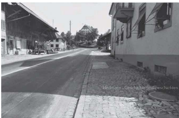
Abbildung 62: Hauptstrasse (heute Zürcherstrasse) 1964. Links: ehemaliges Bauernhaus Familie Widmer - heute Obrist Radsport, oberhalb Bauernhaus Familie Frei (abgebrannt 1983). Rechts: Restaurant Krone (abgerissen 2024), oberhalb eine Scheune (abgebrannt 2003) (Hedingen G&G) 49
