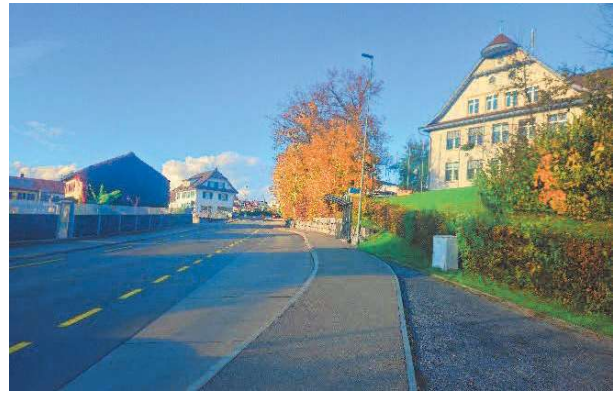
Abbildung 65: Zürcherstrasse mit Lärmschutz, Trottoirs und Velostreifen (SB&LE)
