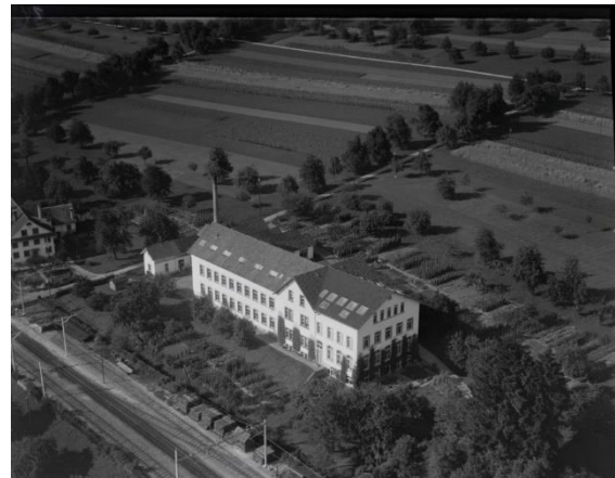
Abbildung 6: Die Seidenweberei Näf; Das Gebäude wurde von der Ernst Schweizer AG übernommen. (Quelle: Wikipedia, Gebrüder Näf)
