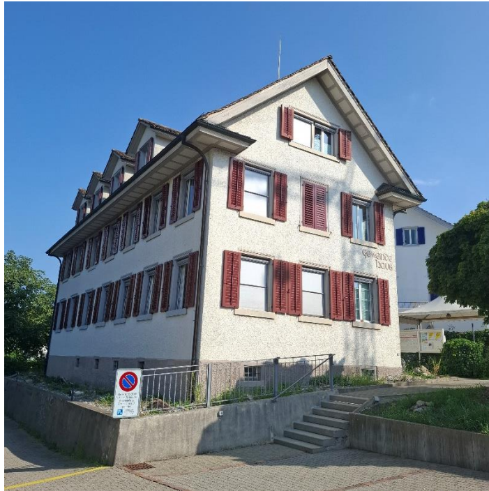
Abbildung 18: Das ehemalige Sekundarschulhaus für Schüler:innen aus den Gemeinden Aeugst am Albis, Affoltern am Albis, Bonstetten, Hedingen, Stallikon und Wettswil am Albis. Es steht an der Zürcherstrasse 27 und dient als Gemeindehaus.
